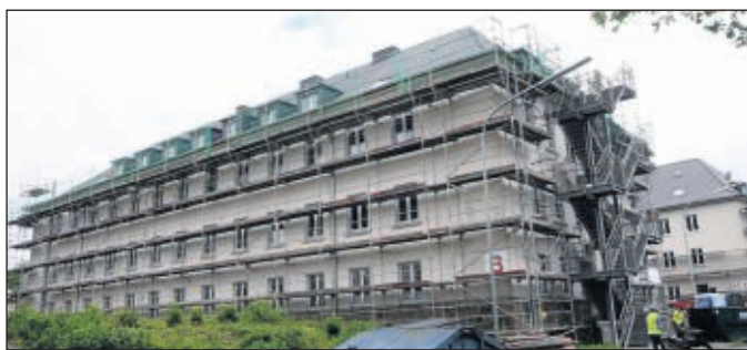
Erneut wurden Schwarzarbeiter auf der künftigen Unterbringungseinrichtung für Asylbewerber erwischt. ■ Foto: Rother
